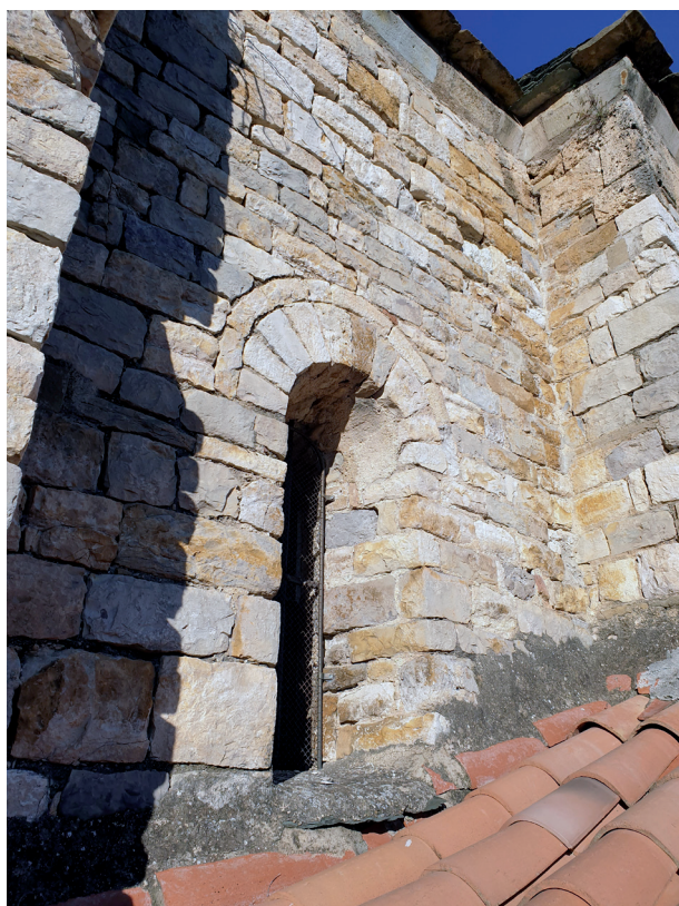
Fig. 49. La fenêtre de la première travée vue de l'extérieur.
