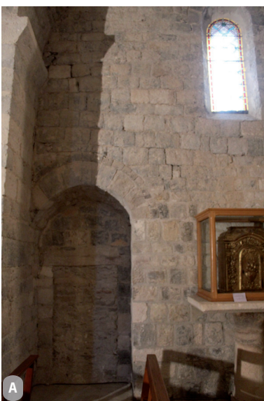
Fig. 45 La reprise autour de la porte, à l'intérieur. (cliché : M. Charrie-Adrian)
