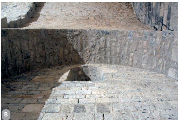
Fig. 62. Les voûtures des arcades des travées 2 (A) et 3 (B). (clichés : M. Charrie-Adrian)
