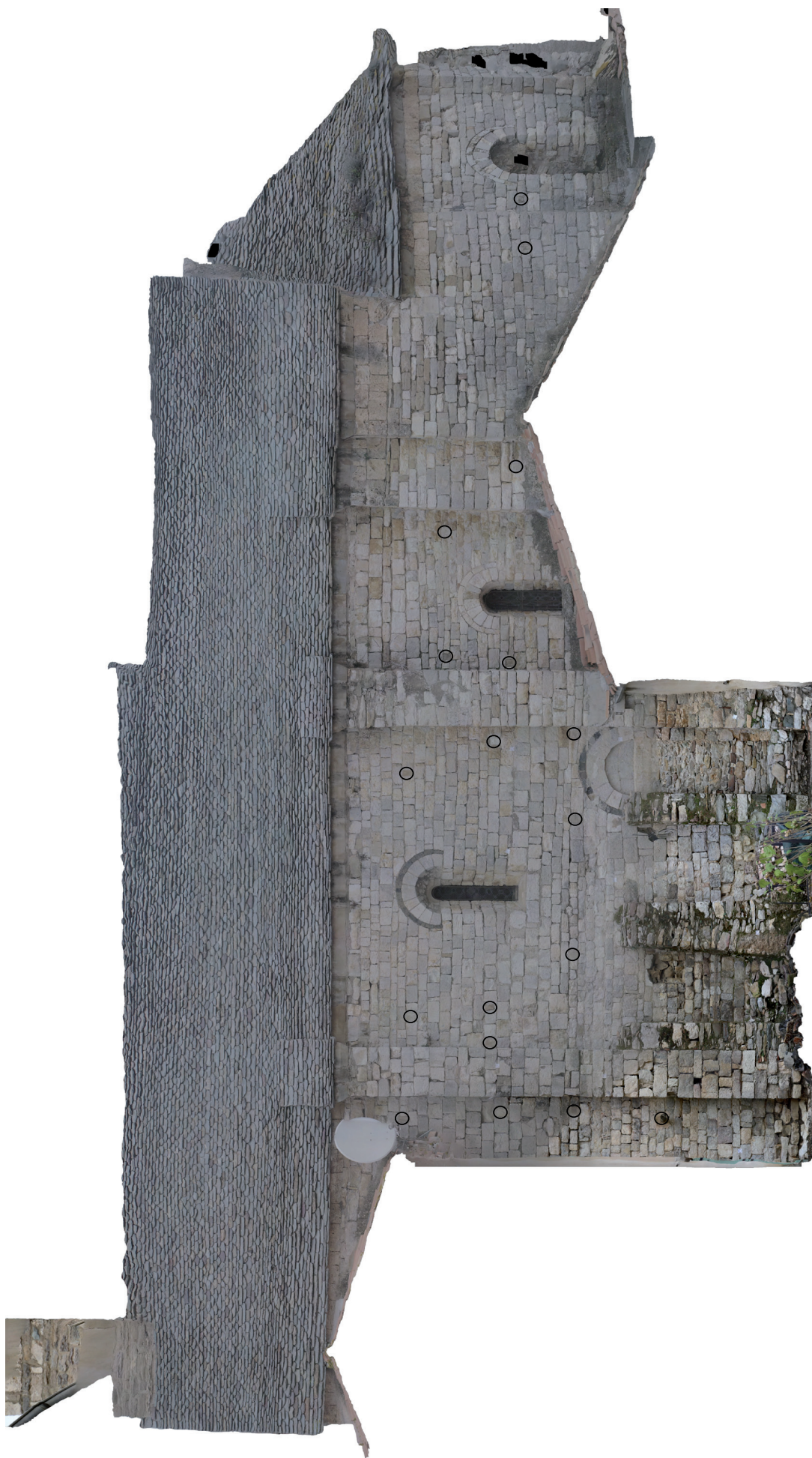
Fig. 41. Indication de l'emplacement des trous de boulins sur l'ensemble de l'élévation méridionale. (photogrammétrie : V. Lauras ; topographie : A. Farge, infographie : M. Charrie-Adrian, St. Barbey)
