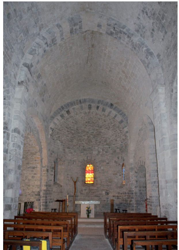
Fig. 63. La voûte au niveau des travées 1 et 2. (cliché : I. Rémy)
