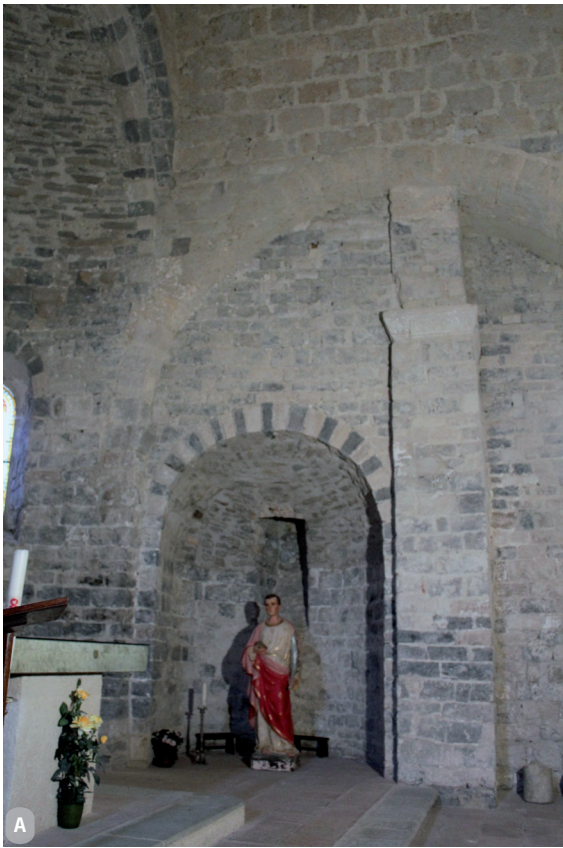
Fig. 33. Vues de face (A) et de côté (B) de l'ensemble formant le premier état de l'abside : la travée droite initiale. (clichés : I. Rémy)
