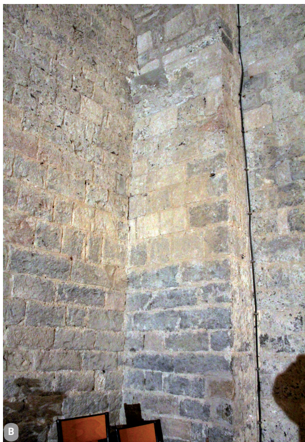
Fig. 55. La reprise en escalier, vers la pile du mur sud, qui marque le début de la reconstruction (A), la continuité des assises au niveau de l'angle avec le mur de façade (B), de même qu'avec le mur nord, où l'on note la reprise au-dessus du portail (C). (clichés : M. Charrie-Adrian)
