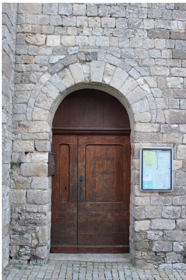
Fig. 25 Le portail de l'église se trouve dans le mur nord. (cliché : I. Rémy)
