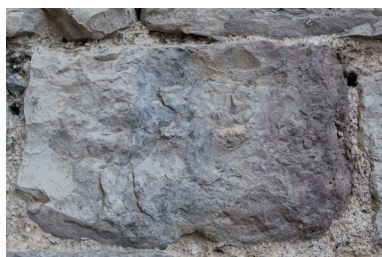
Fig. 39 Un moellon de calcaire lacustre avec traces de feu. (cliché : I. Rémy)
