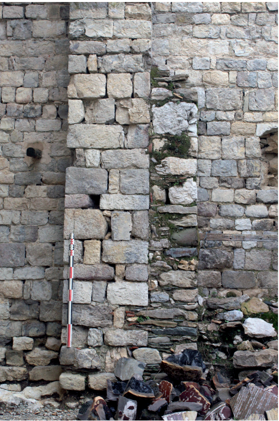
Fig. 31. Le pilier ouest. (cliché : I. Rémy)
